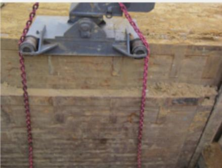
**01** Mit dem Hydraulikantrieb wird das Kettenrad angetrieben und hochgezogen.
