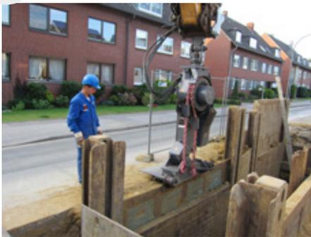
**01** Der Verbauzieher wird mittig am Rand auf der zu entfernenden Verbauplatte positioniert.
